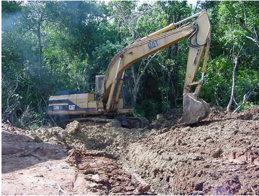
Figura 8; Jumbo Abriendo un Canal para Drenar el Agua.
